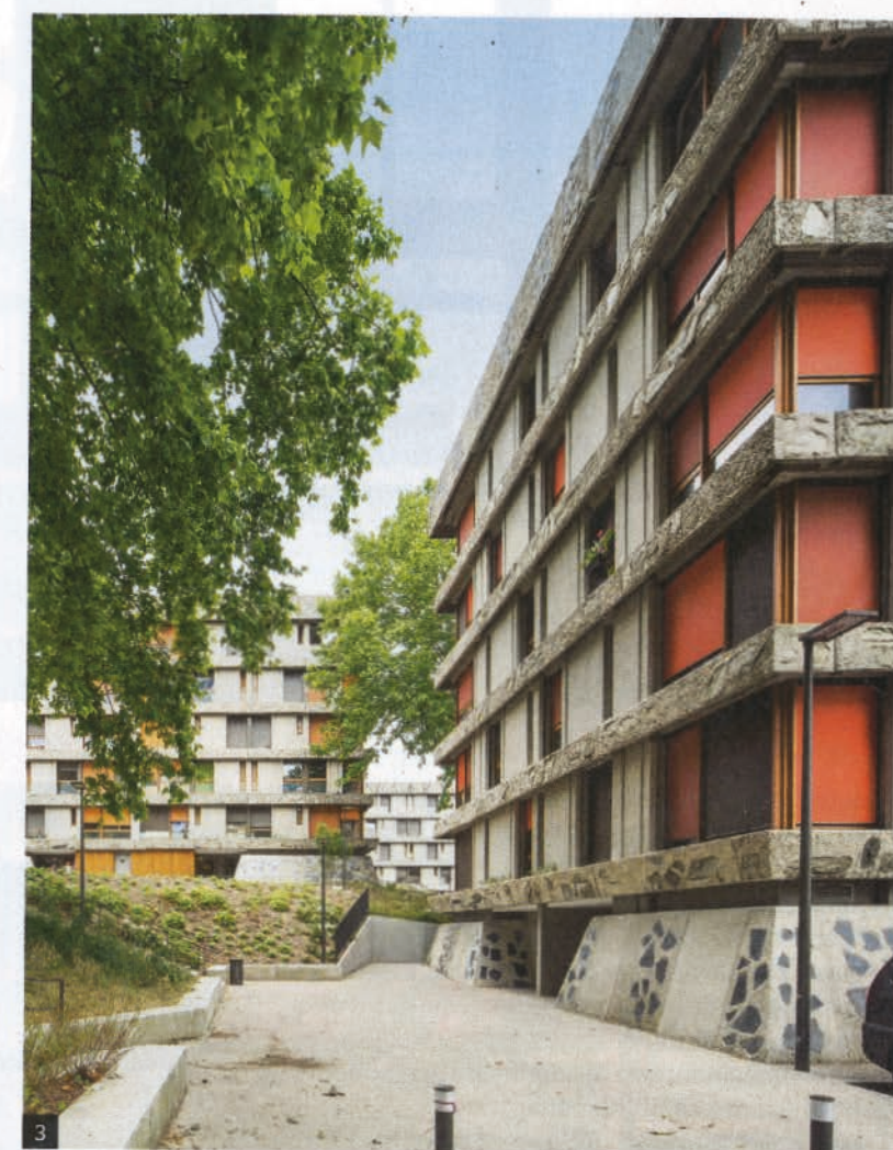
1 - Le quartier des Bleuets au début des années 1960. Il articulait 10 barres de cinq étages au sein d'un parc paysager. 2 et 3 - Le bâtiment H avant (2) et après restauration (3). Son socle pyramidal a été reconstitué. 4 - Les façades sont en éléments de béton préfabriqués puis emboîtés à joints creux. Des trumeaux cannelés et lisses alternent avec les baies vitrées. De rustiques bandeaux saillants marquent les étages et les acrotères.
