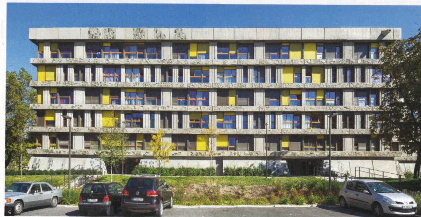
1 - Le quartier des Bleuets au début des années 1960. Il articulait 10 barres de cinq étages au sein d'un parc paysager. 2 et 3 - Le bâtiment H avant (2) et après restauration (3). Son socle pyramidal a été reconstitué. 4 - Les façades sont en éléments de béton préfabriqués puis emboîtés à joints creux. Des trumeaux cannelés et lisses alternent avec les baies vitrées. De rustiques bandeaux saillants marquent les étages et les acrotères.
